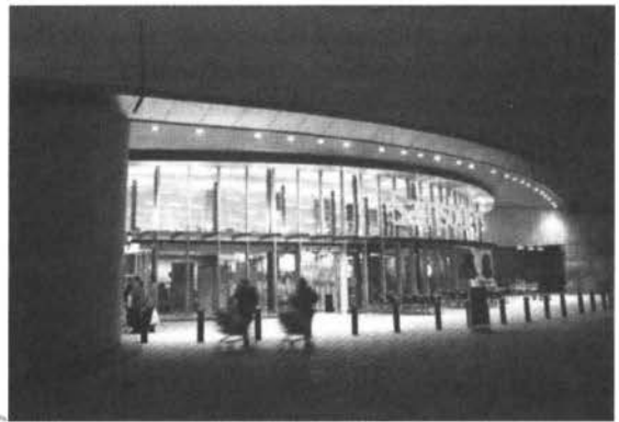
Supermercado Sainbury's, Greenwich, Inglaterra. Arquitectura mediática de fin de siglo.
