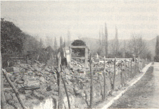
Fotografía N° 1: Vista parcial del Sector Sur de Villa Alhué cinco meses después del terremoto de marzo de 1985.
