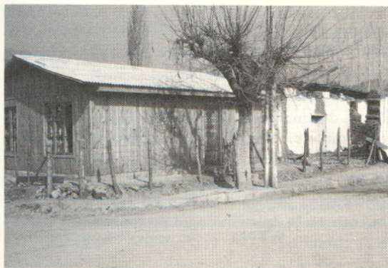
Fotografía N° 3: La tradicional casa de adobe fue seriamente afectada por el sismo. Una consecuencia directa es la aparición de la vivienda de madera en su reemplazo.
