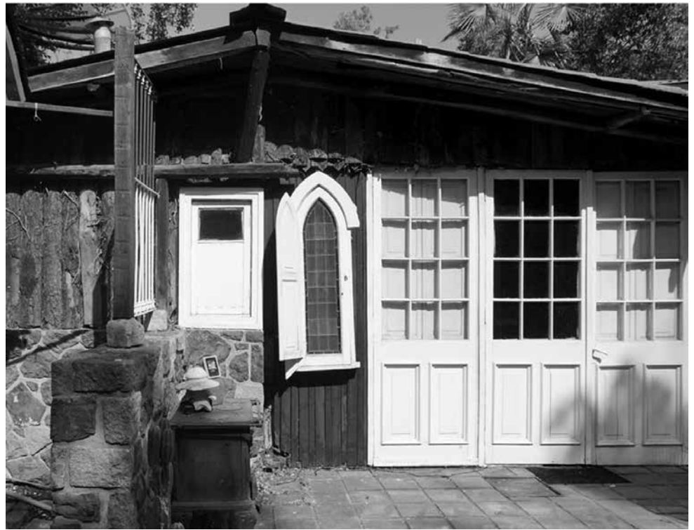
FIG. 07: Marco de ventana en la fachada sur de la Cabaña. © Maite Raschilla.
