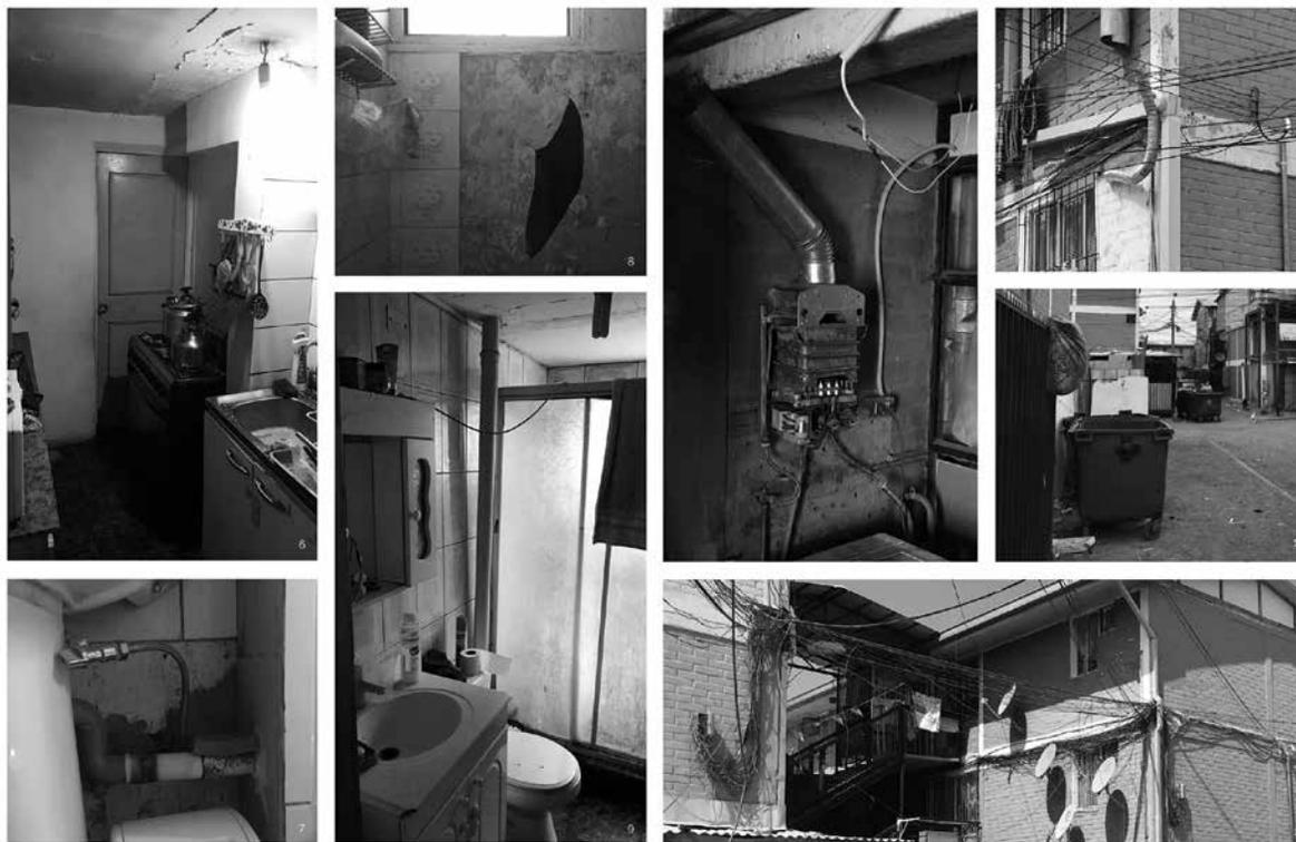
FIG. 05: Serie de fotografías al interior y exterior de los bloques que registran de izquierda a derecha: la humedad, las filtraciones y el desprendimiento del revestimiento interior. La materialidad de las tuberías a la vista. El calefón original y su conducto de ventilación. Los basureros en la copropiedad y la acumulación de antenas y cables que viajan por las fachadas hacia cada vivienda. Fuente: Pesquisa realizada en terreno, en colaboración con Charles Louis Lavanchy.
