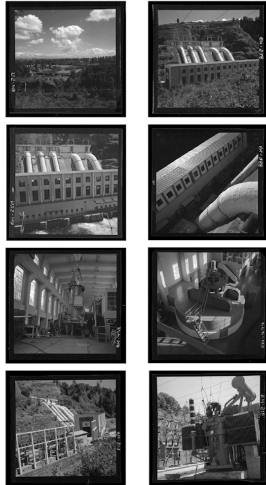
Ítem 02: Fotografías infraestructura central Pilmaiquén. Luis Ladrón de Guevara 1950.
