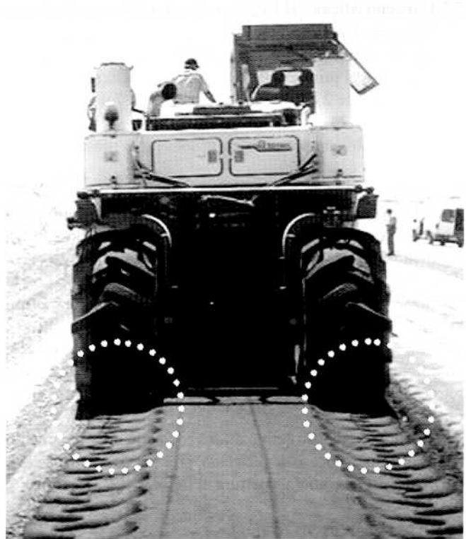
Figura 13. Huellas producidas por la máquina de reciclado
