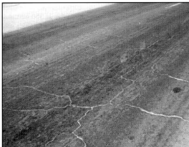
Figura 4. Falla típica en pavimento envejecido original
