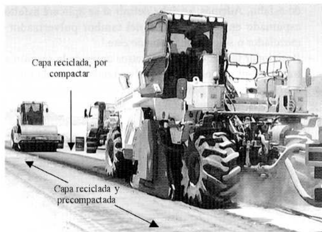
Figura 12. Proceso de precompactación detrás del tren de reciclado
