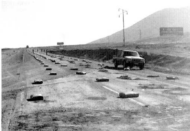
Figura 11. Sacos de cemento sobre el pavimento a reciclar
